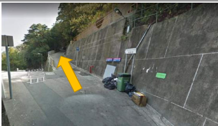
88. 沿舊山頂道經過纜車橋向上靠右接種植道
