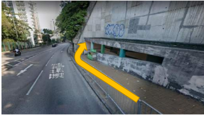
109. 沿薄扶林道轉入行人隧道橫過薄扶林道
