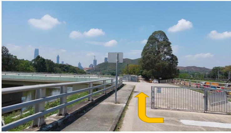
21. 橋面越過梧桐河
