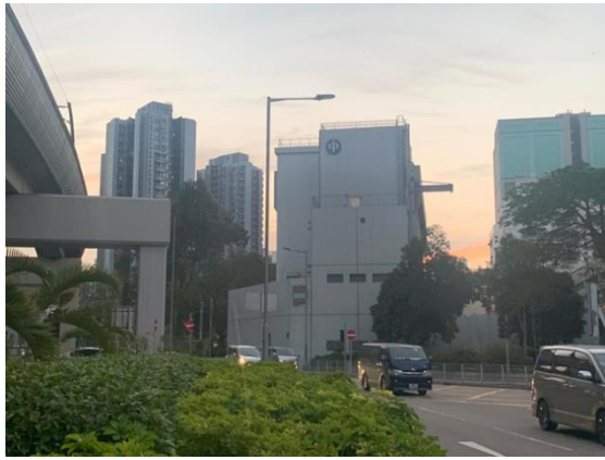
33. CP6 - 安樂路電力站(41.3 km)
